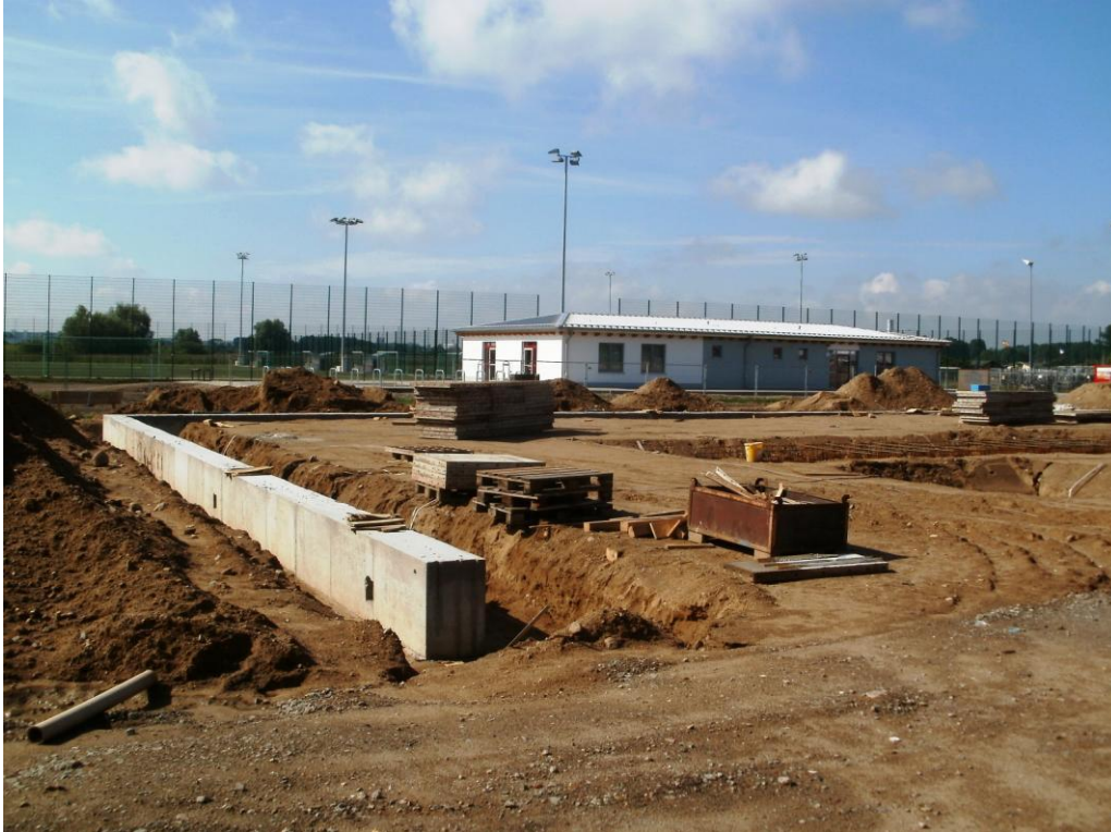
Vorbereitung des Fundamentes
