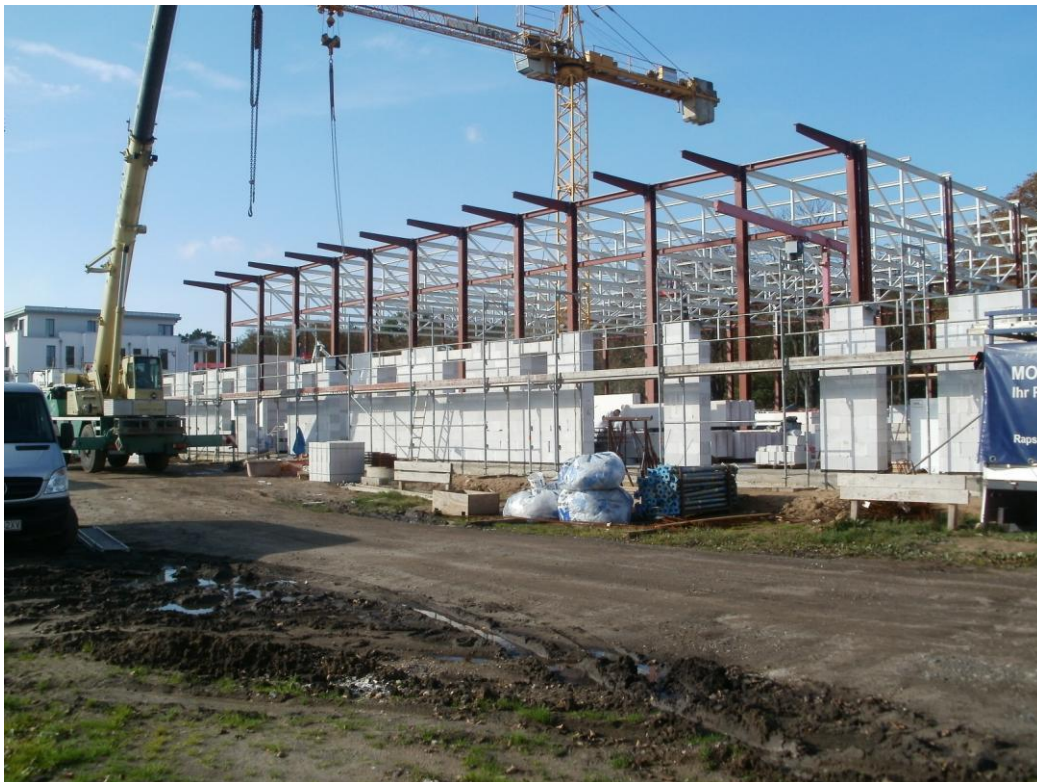
Das Hallengerüst und Wände werden errichtet.
