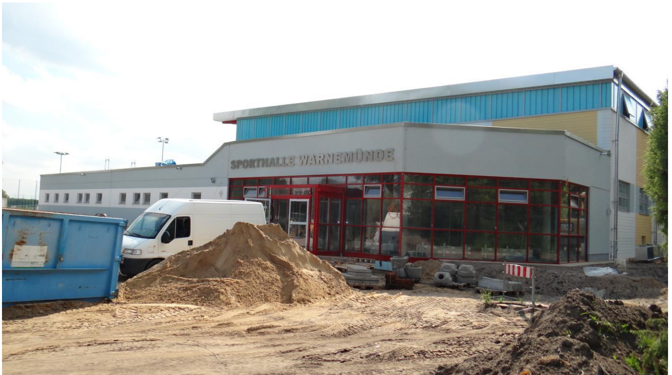
Juli 2015, der Eingangsbereich
